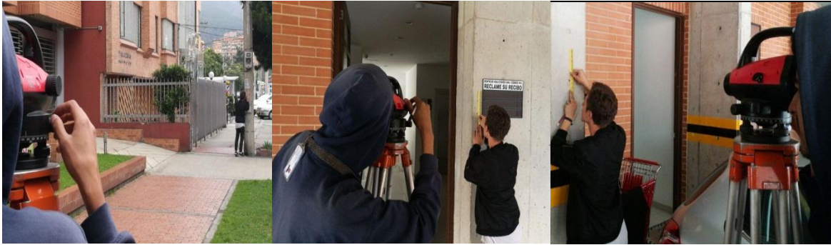
Figura 4 Control de asentamientos Balcones del Cedro
