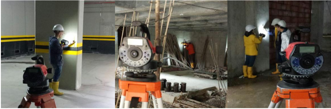
Figura 3 Materialización de niveletas
