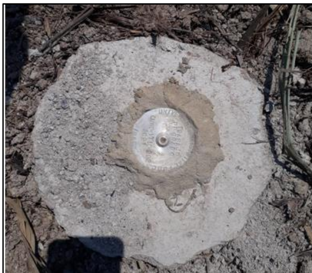
Fotografía 3: Punto materializado Fuente: Elaboración propia
