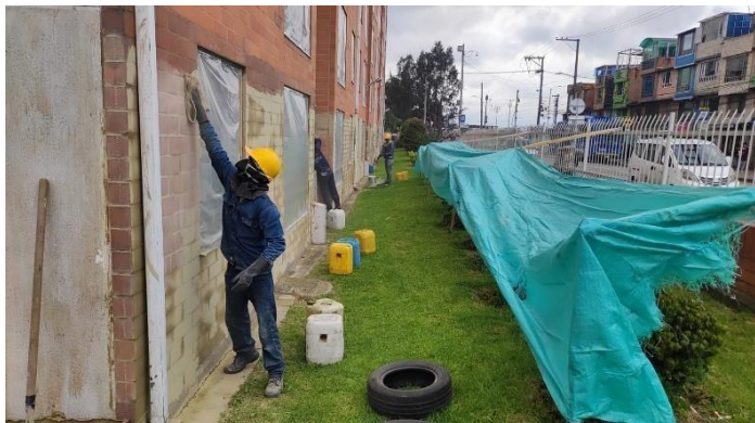
Ilustración 19. Limpieza de boquilla (Madeiro 1)
