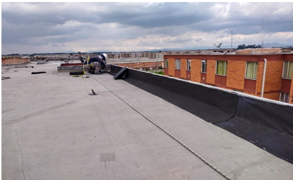
Ilustración 41. Instalación geotextil en antepecho (Porvenir)
