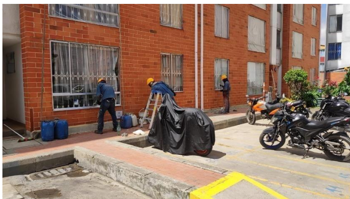
Ilustración 25. Cambio de rejillas (Madeiro 1)
