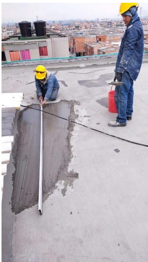
Ilustración 36. Tratamiento de empozamientos (Porvenir)
