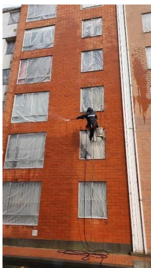
Ilustración 22. Lavado de ladrillo (Madeiro 1)
