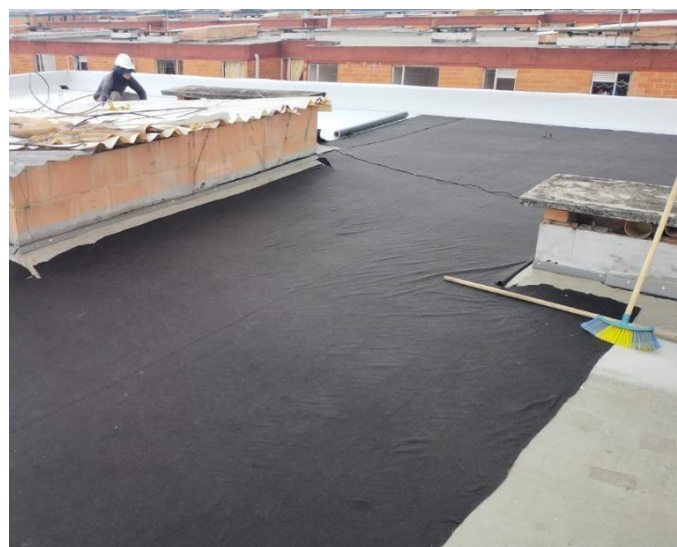
Ilustración 42. Instalación de geotextil en placa (Porvenir)
