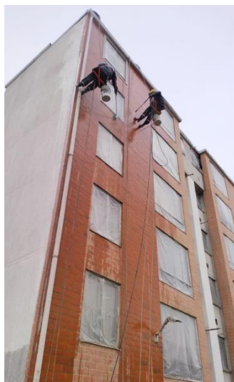
Ilustración 20. Lavado ladrillo (Madeiro 1)
