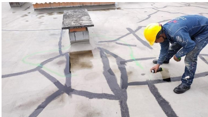
Ilustración 37. Marcar empozamientos
