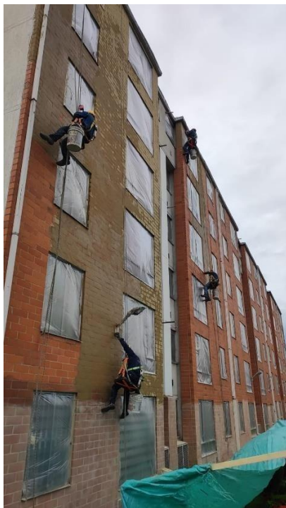
Ilustración 16. Emboquillado con mortero (Madeiro 1)
