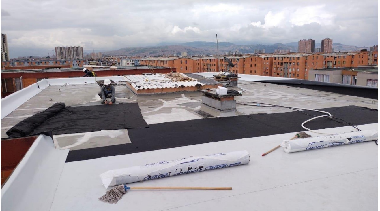
Ilustración 44. Instalación geotextil y membrana PVC en placa (Porvenir)
