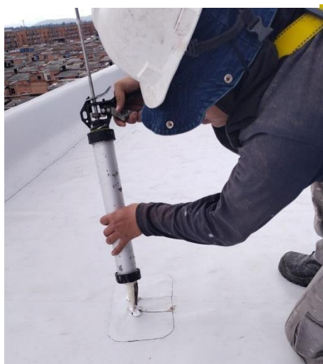
Ilustración 49. Aplicación preparadores de superficie (Porvenir)
