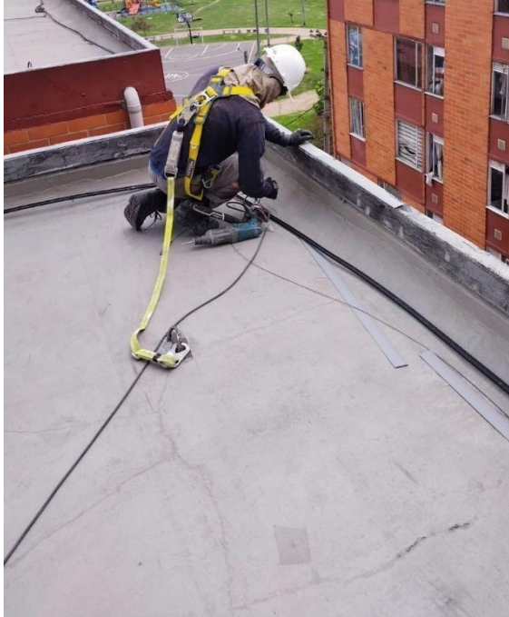
Ilustración 39. Instalación perfilera PVC en antepechos (Porvenir)
