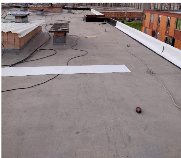
Ilustración 43. Instalación membrana PVC en antepecho (Porvenir)
