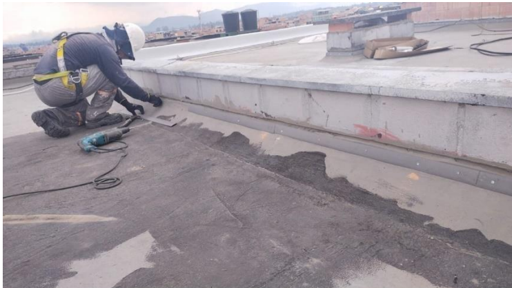
Ilustración 40. Instalación perfilera PVC (Porvenir)
