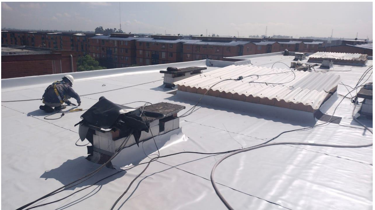
Ilustración 51. Termofusión de membrana PVC (Porvenir)
