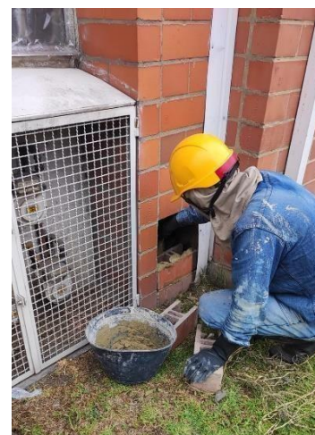
Ilustración 26. Cambio de piezas (Madeiro 1)
