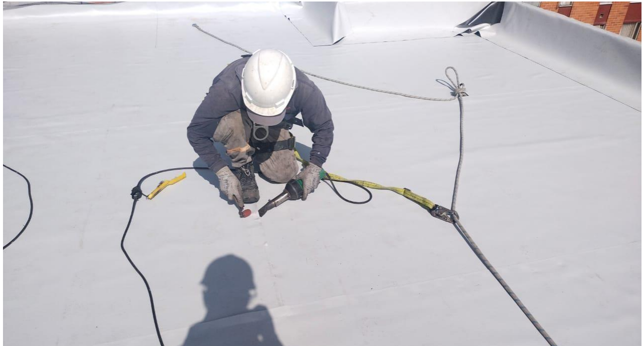
Ilustración 50. Termofusión de membrana PVC (Porvenir)
