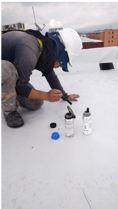
Ilustración 49. Aplicación preparadores de superficie (Porvenir)
