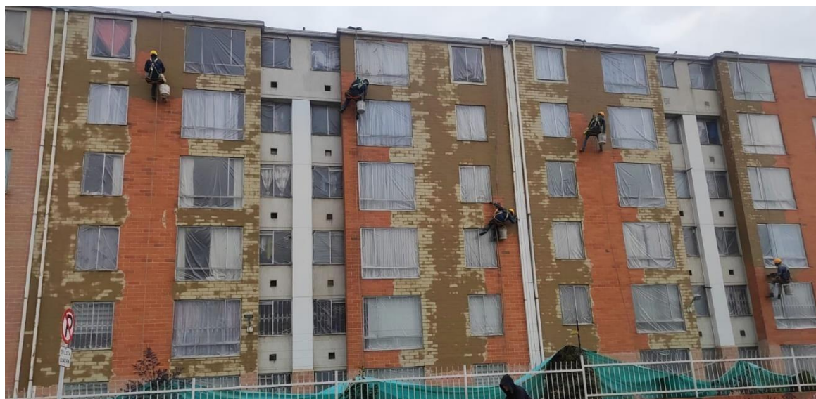
Ilustración 18. Emboquillado con mortero (Madeiro 1)
