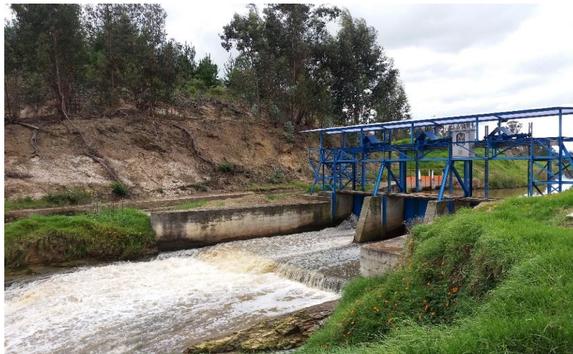
Figura N° 8. Compuertas del Cubio. Copyright 2018. Por el Autor
