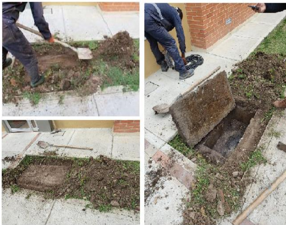
Figura 6. Mantenimiento cajas de inspección.
