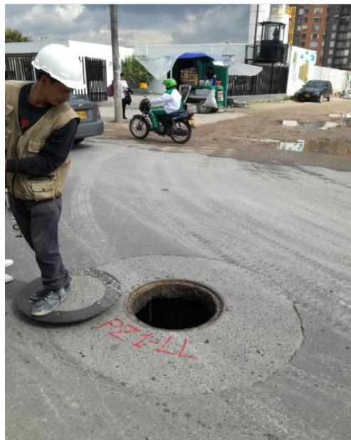
Ilustración 14 . Inspección de pozo 1 pluvial. (Fuente propia)
