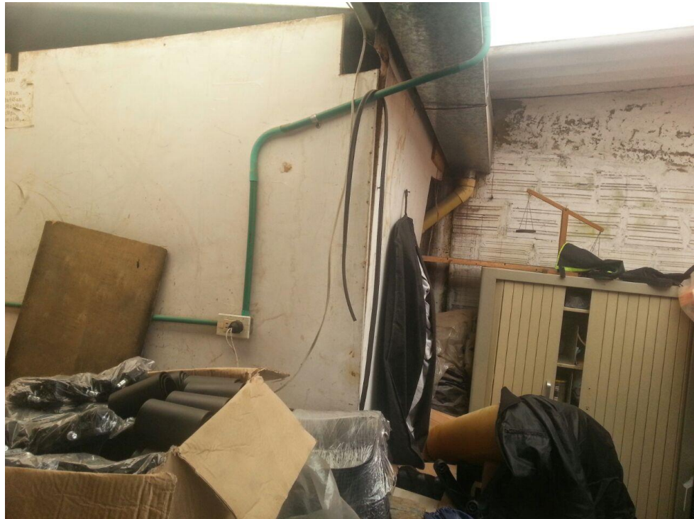
Condiciones de las instalaciones
