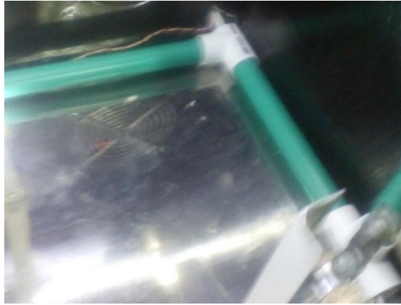
Figura 15. Tubería eléctrica de los respectivos actuadores.
