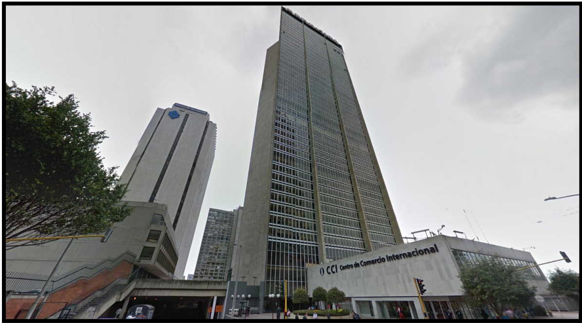
Figura 15. Edificio Calle 28 13A 15
