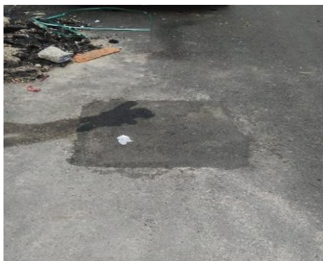
Figura 24. Parche en la carpeta asfáltico Fuente: Propia
