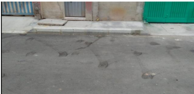
Figura 23. Ahuellamiento en la carpeta asfáltica. Fuente Propia
