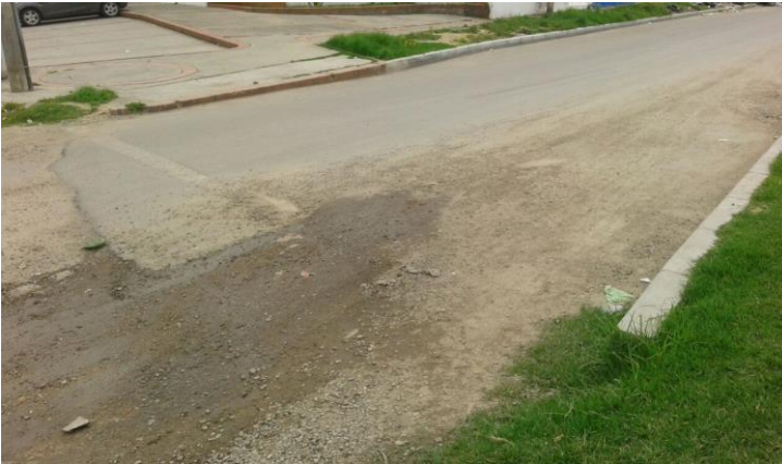
Figura 26. Desgaste carpeta asfáltica Fuente: Propia
