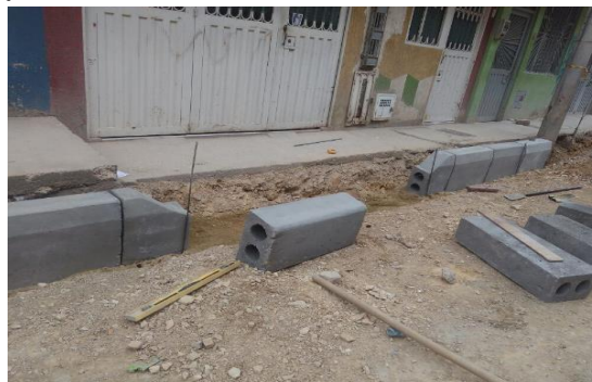
Figura 14. Instalación de sardinel A 85 Fuente propia
