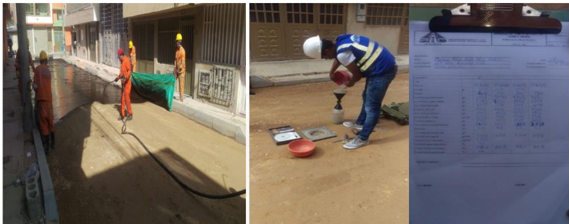
Conjunto de imágenes 11 de octubre del 2016 (Riego de liga, ensayo de densidad de campo por el método del Cono y Arena de la base granular (anexo hoja de seguimiento))
