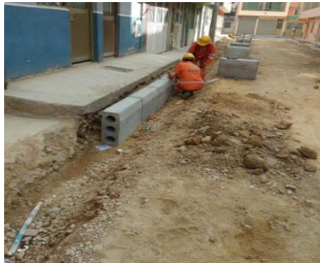
Figura 13. Instalación de sardinel A 10 Fuente: propia
