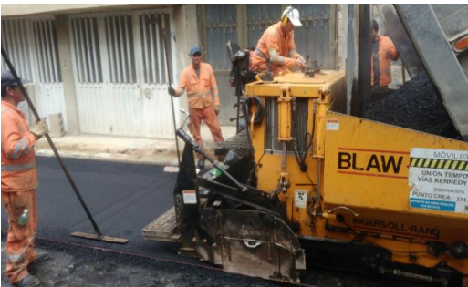
Figura 20. Extensión de mezcla asfáltica Fuente: propia
