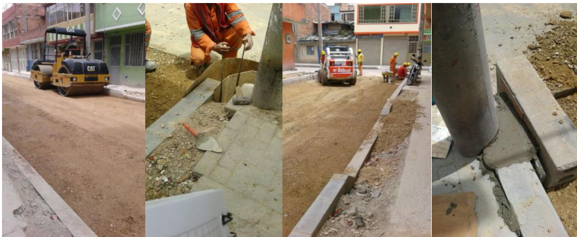
Conjunto de imágenes 11 de octubre del 2016 (instalación de sardineles, Mantenimiento e inspección de poso, vibro compactación)
