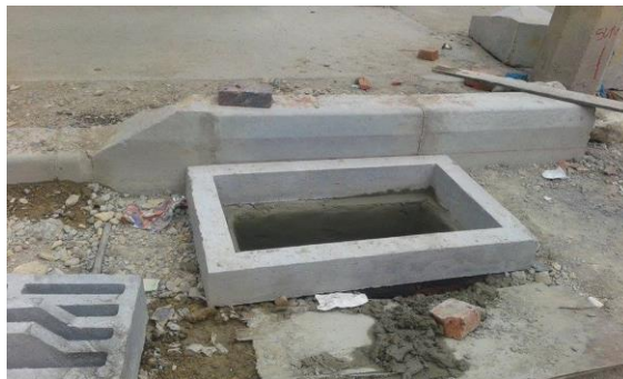
Figura 22. Instalación de sumideros Fuente: propia
