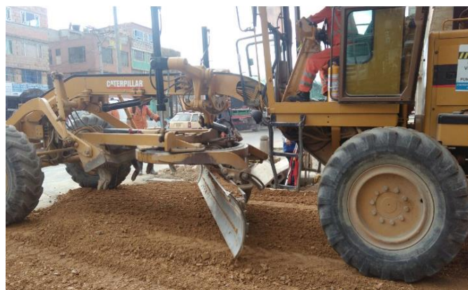
Figura 16. Extensión y nivelación de base granular Fuente: propia
