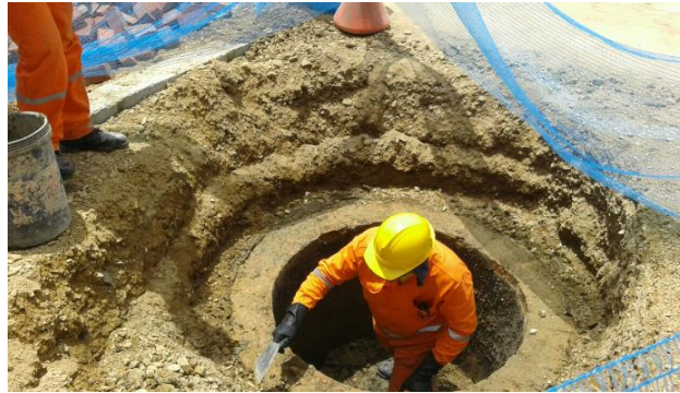
Figura 17. Excavación y nivelación de pozo de inspección Fuente: propia
