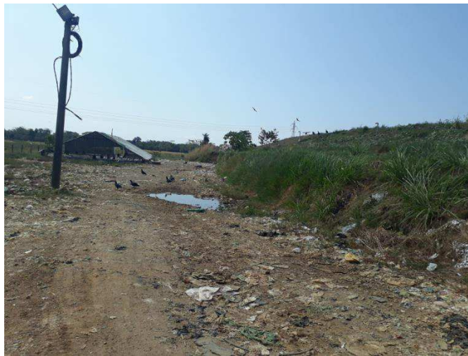
Foto N° 5. Lixiviados generados por proceso de relleno sanitario. Fuente: Autores
