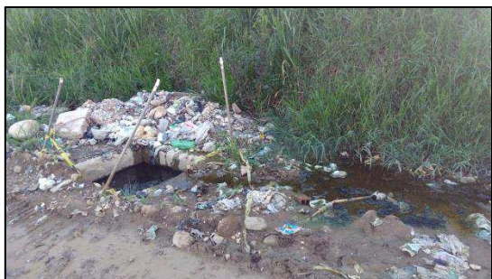
Foto N° 22 Cajas de conducción de lixiviados rebosada. Foto N° 23 Infiltración de lixiviados Fuente: Autor
