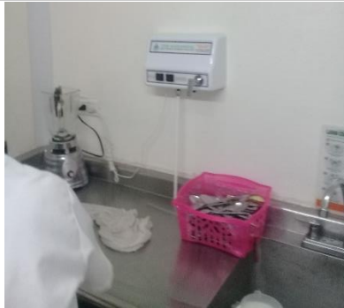
Filtro purificador de agua
