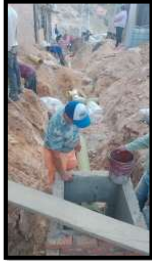
Ilustración 14: Cajas y tuberías domiciliarias
