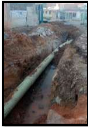
Ilustración 13: Instalación de tubería principal
