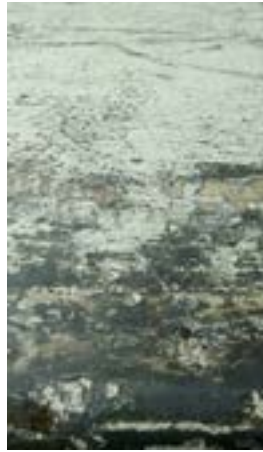
Fotografía detalle de borde de cemento con pintura blanca.
