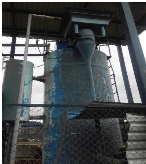
Imagen 10. Cono de mezcla rápida (coagulación)
