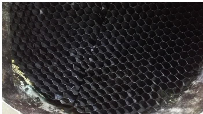
Imagen 11. Sistema modular de sedimentación.
