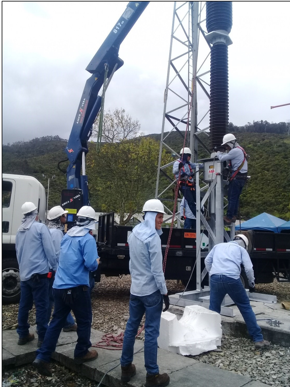
Anexo 13 Cambio Interruptor Guavio I, S/E Torca
