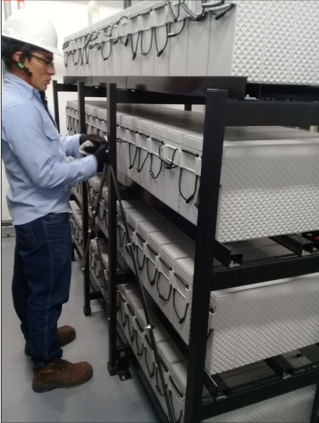
Anexo 19 Mantenimiento Banco de baterías STATCOM
