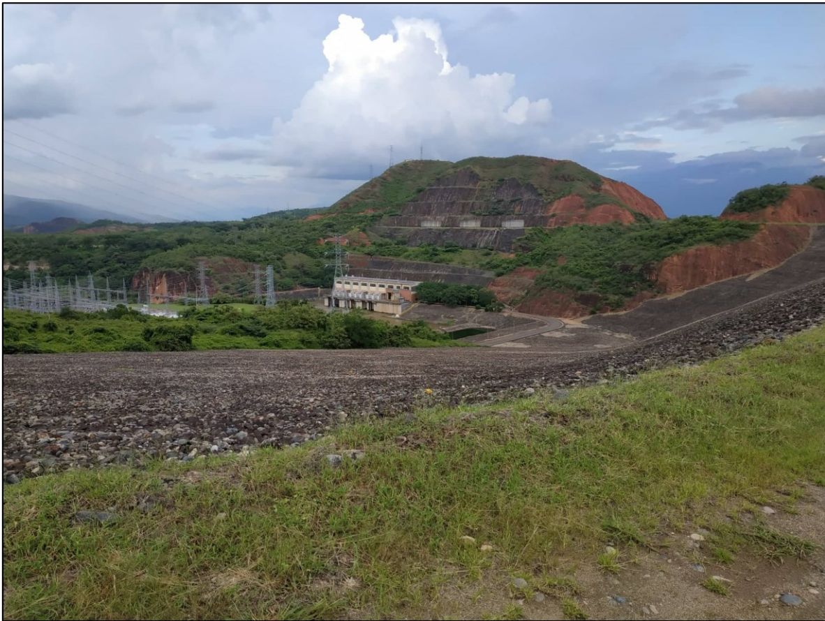
Anexo 5 Subestación Betania y Casa de Maquinas Central
