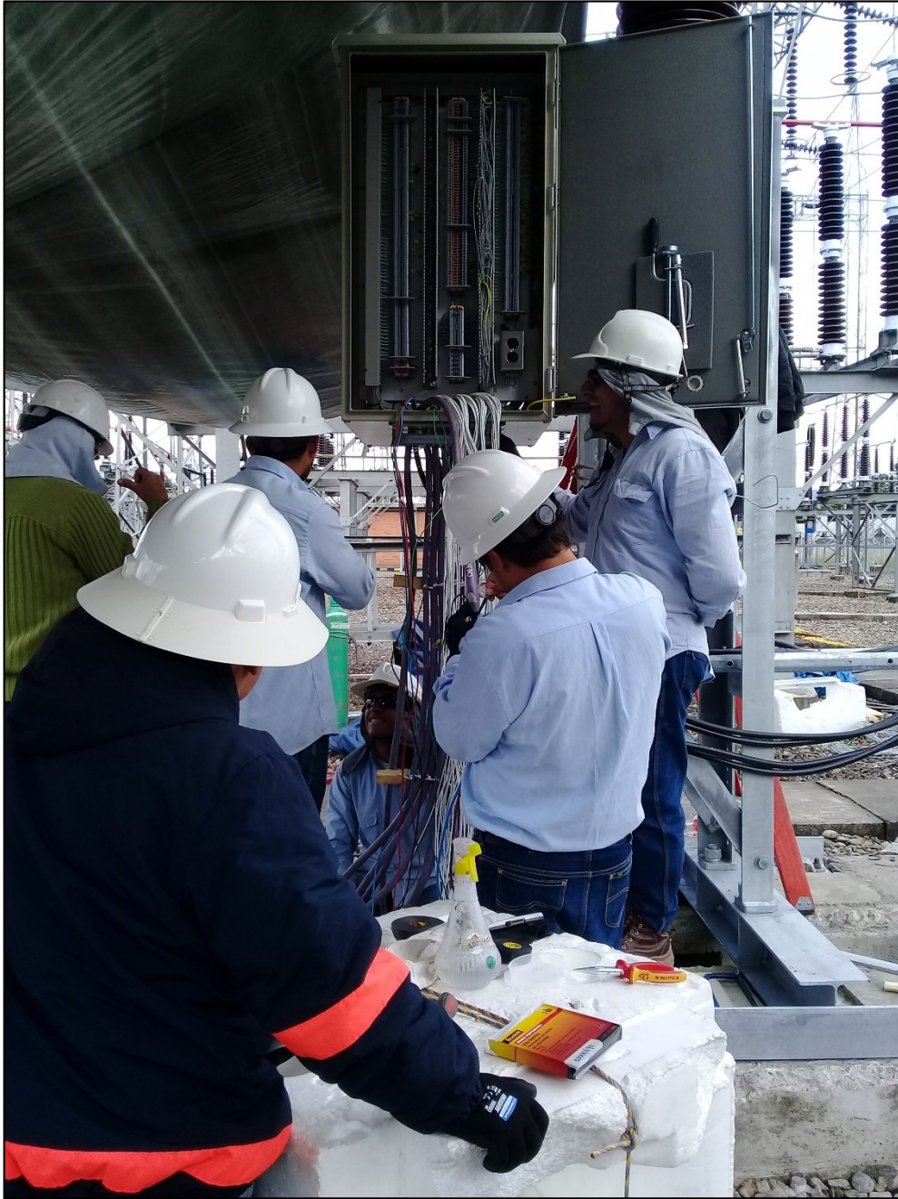
Anexo 14 Cableado Interruptor Guavio I S/E Torca
