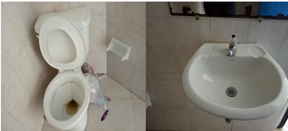
Imagen 19 Baños Casa de la Cultura
