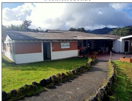
Figura 27. Centro administrativo Monterredondo
