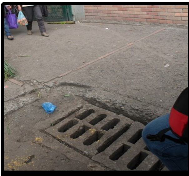
Figura 10. Alcantarillado a la entrada de SOGABASTOS, en el cual eventualmente se depositan residuos de aceites de cocina usados.
