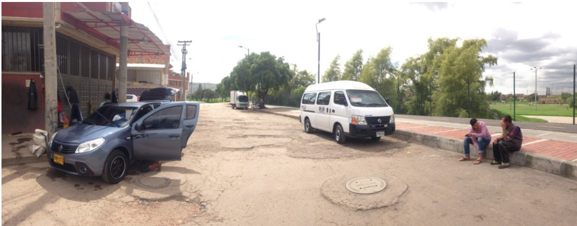
Foto 6. Vía antes de ser intervenida Tr. 72V Bis entre Cll.42 B s y Cll.45 s Fuente: Propia
