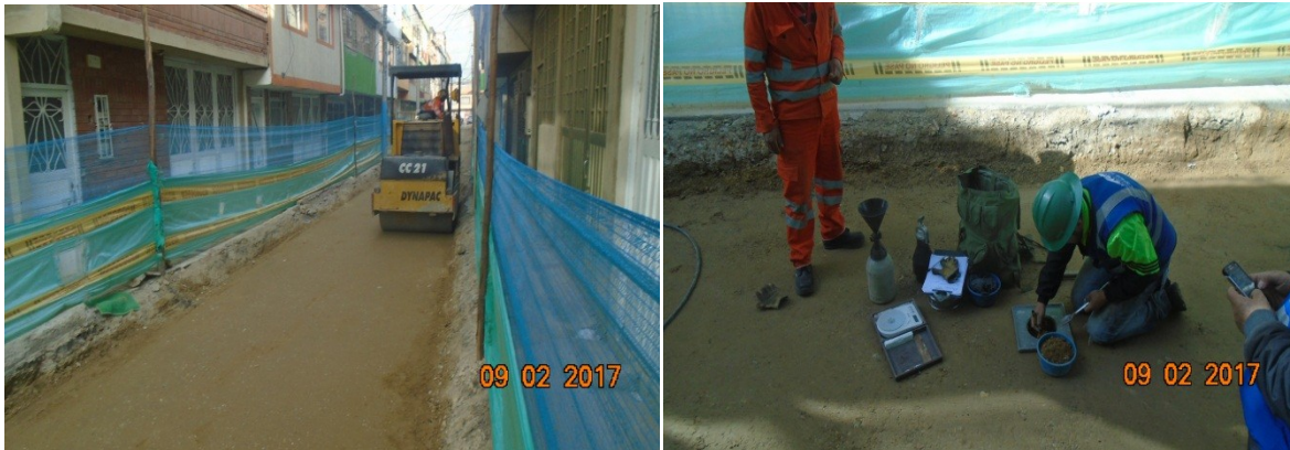
Foto 11. Proceso constructivo Fuente propia
