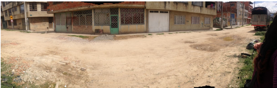
Foto 7. Vía antes de ser intervenida Cra.72u Bis entre Cll.45s y Cll.48Bs
