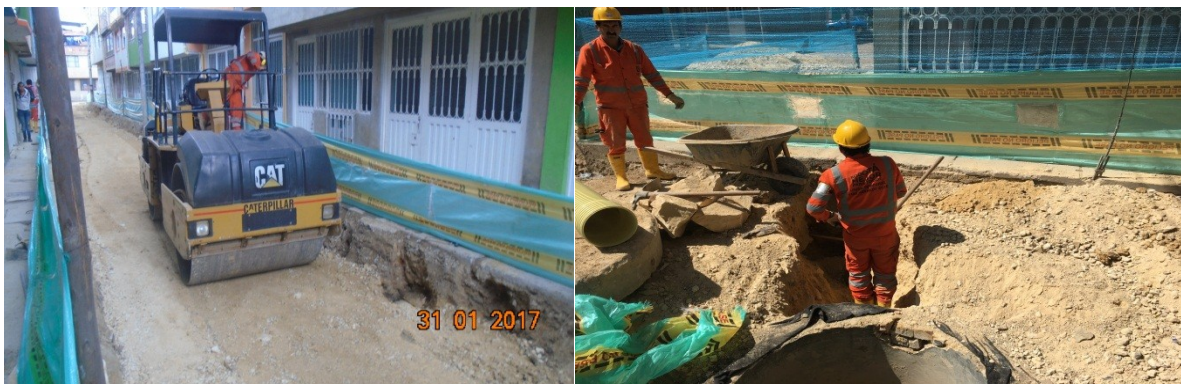
Foto 10. Proceso constructivo Fuente propia
