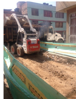
Foto 3. Control y construcción del Instituto de Desarrollo Urbano ET-2011.
