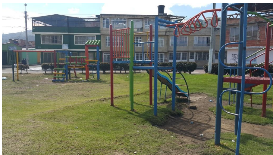
Parque Infantil (Reparado)
