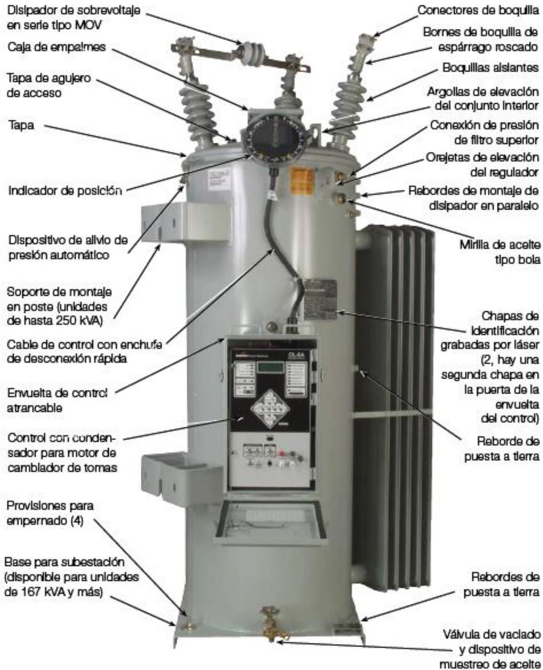
Figura 36. Características externas del regulador de tensión Vr-32 (TOSHIBA, 2012)
