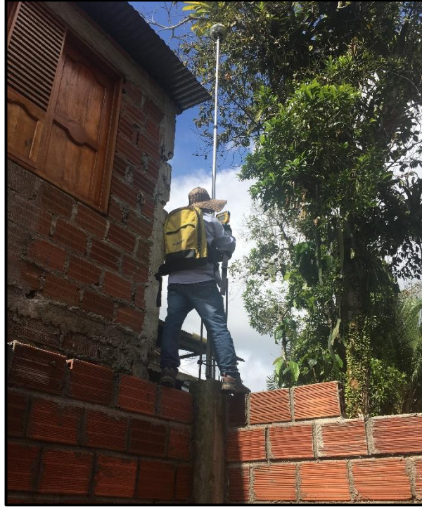
Ilustración 13. Levantamiento RTK. Fuente propia.
