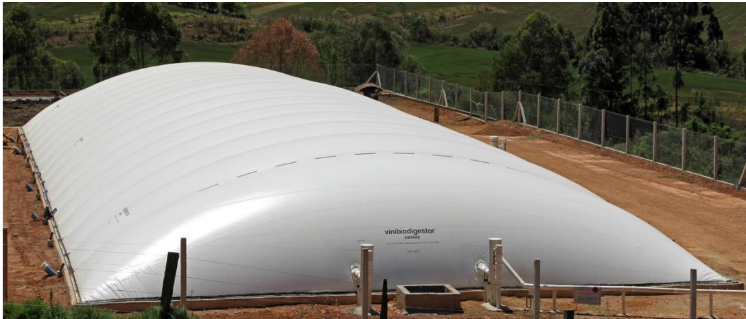
Figura 16. Biodigestor tipo laguna.
