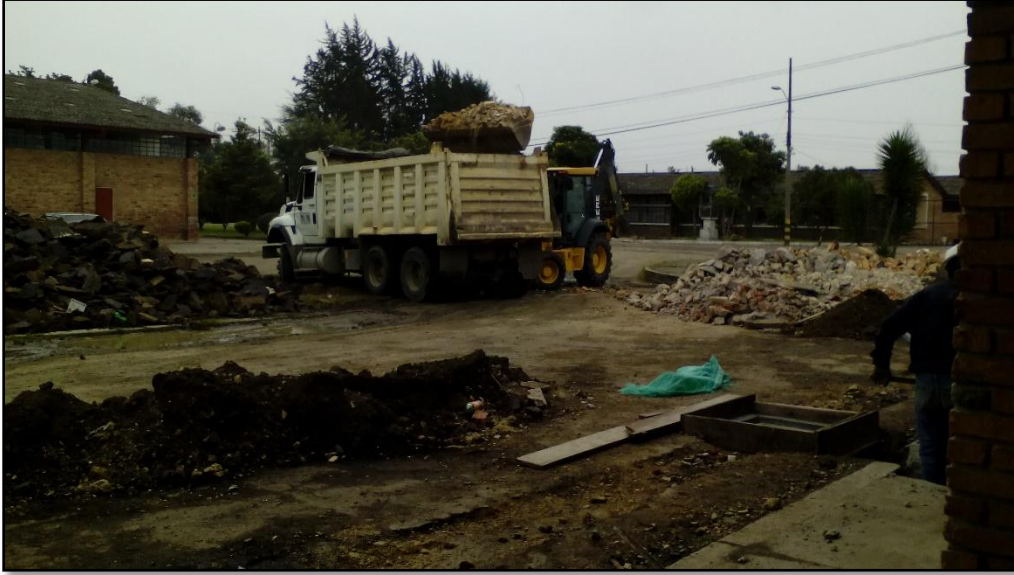
IMAGEN 4. RECOLECCION ESCOMBRO OBRA ICA
