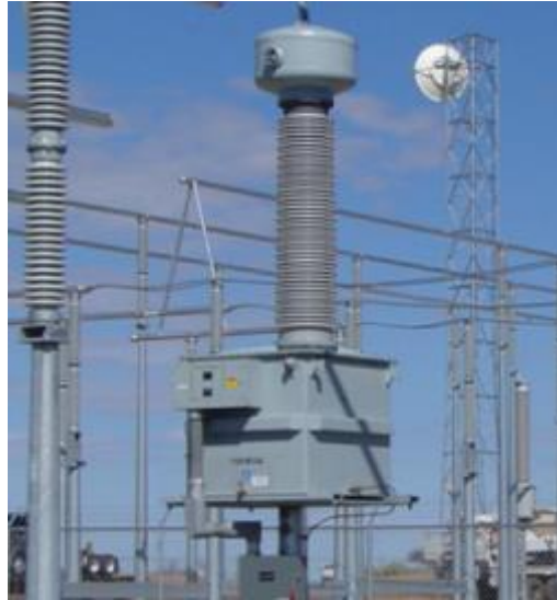
Figura 7. Transformador de corriente para alta tensión, (ABB, 2017)
