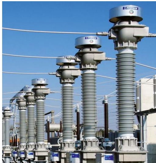
Figura 8. Transformador de potencial 24-170 kV, (PFIFFNER, 2017)
