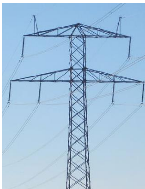
Figura 11. Torre de suspensión con circuito doble 400kV (Qingdao megatru equipo mecánico y eléctrico Co., 2014)
