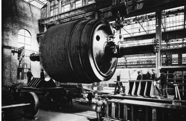
Imagen 3 Fabricación de uno de los generadores de electricidad del Titanic
