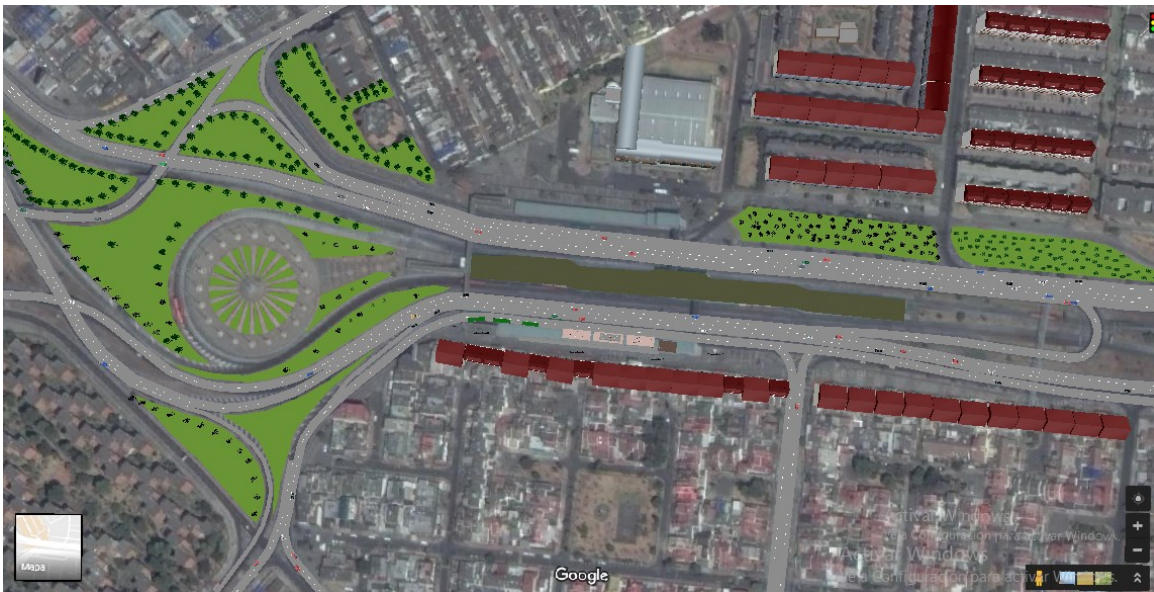
Figura 30. Vista panorámica de la estación Banderas
