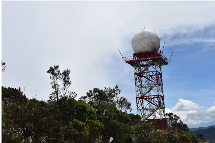
Figura 36. Radar WRM200 Vaisala sector Tablazo (Elaboración propia)
