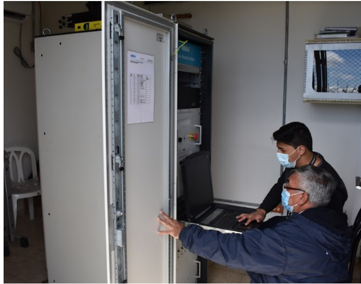
Figura 23. Realizando diagnóstico del radar WRM200 Sector Tablazo (Elaboración propia)
