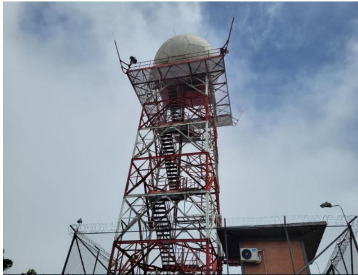
Figura 8. Cuarto de control y torre del radar Vaisala WRM200 (Elaboración propia)
