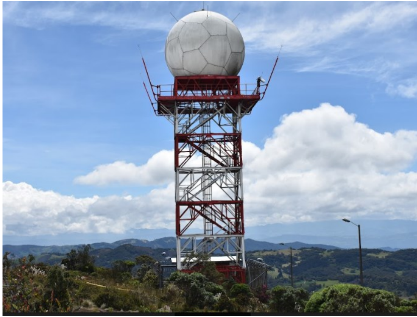
Figura 7. Radar meteorológico Vaisala WRM200 sector Tablazo (Elaboración propia)
