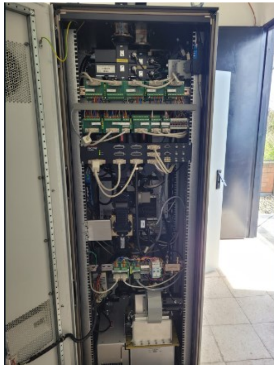
Figura 35. Componentes RAC Vaisala WRM200 sector Tablazo (Elaboración propia)
