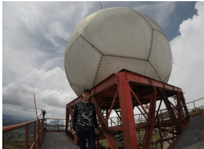
Figura 24. Reconocimiento del radomo de la antena del radar WRM200 (Elaboración propia)
