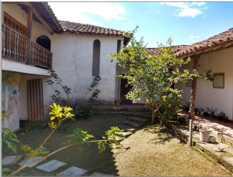
Ilustración 32. Detalle de patio interior: Fuente: Captura propia.
