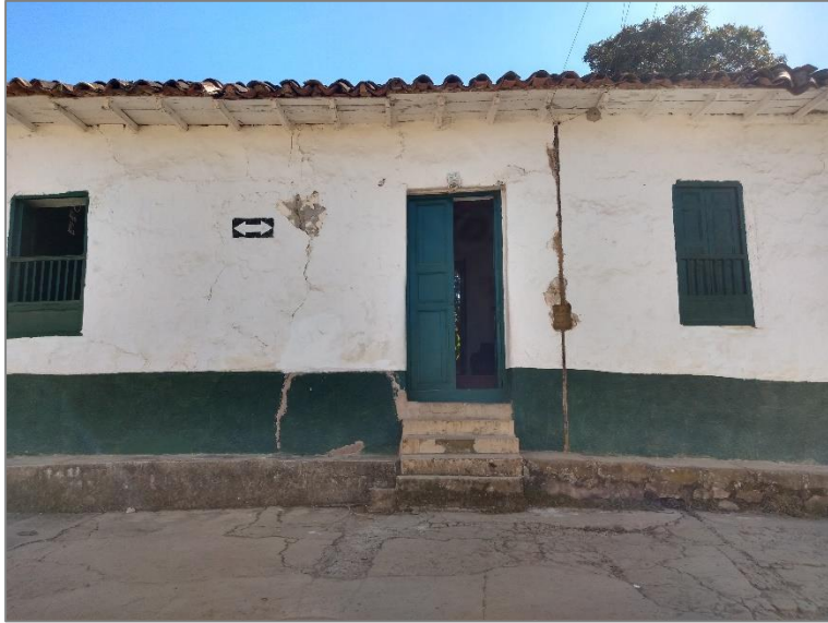
Ilustración 23. Detalle del acceso. Fuente: Captura propia.
