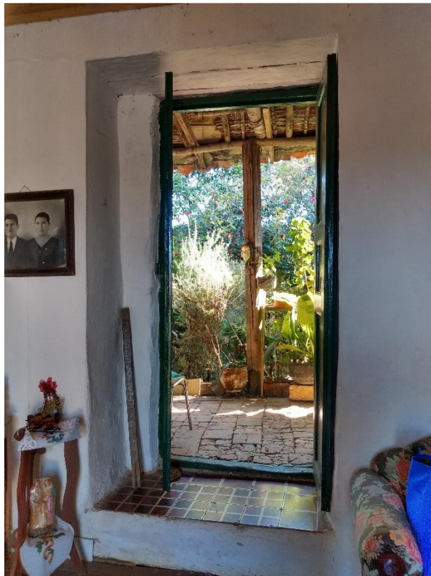
Ilustración 24. Detalle carpintería y niveles – hall de acceso. Fuente: Captura propia.
