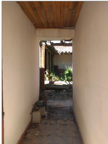
Ilustración 12. Vista parcial interior del objeto de estudio 1. Fuente: Captura propia.
