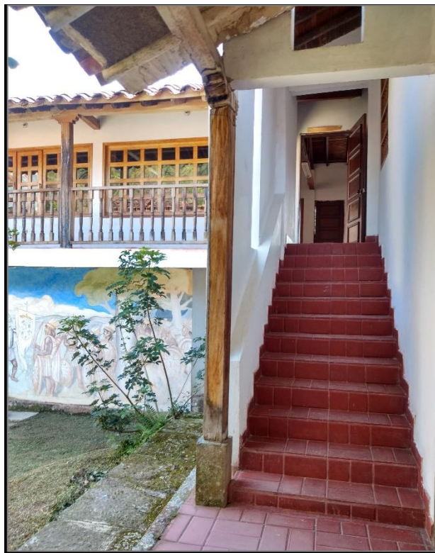
Ilustración 34. Detalle de escaleras hacia segunda planta. Fuente: Captura propia.
