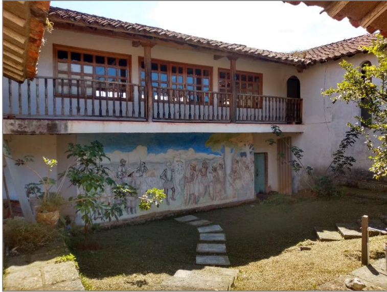
Ilustración 31. Detalle de patio interior. Fuente: Captura propia.
