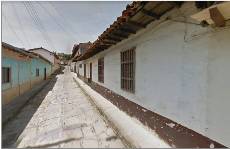
Ilustración 29. Fachada objeto de estudio 2. Fuente: Google Street View.
