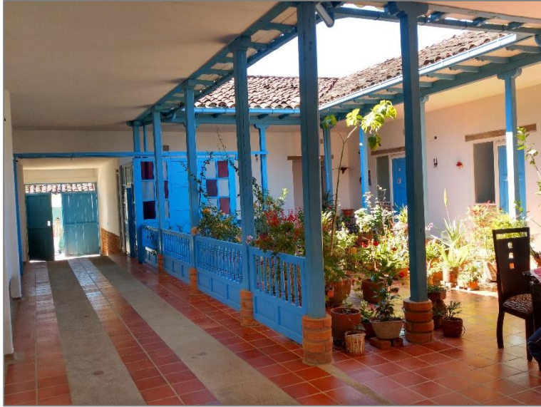
Ilustración 38. Detalle de circulación y patio interno. Fuente: Captura propia.
