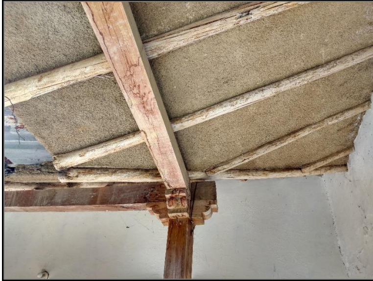
Ilustración 33. Detalle de cubierta. Fuente: Captura propia.
