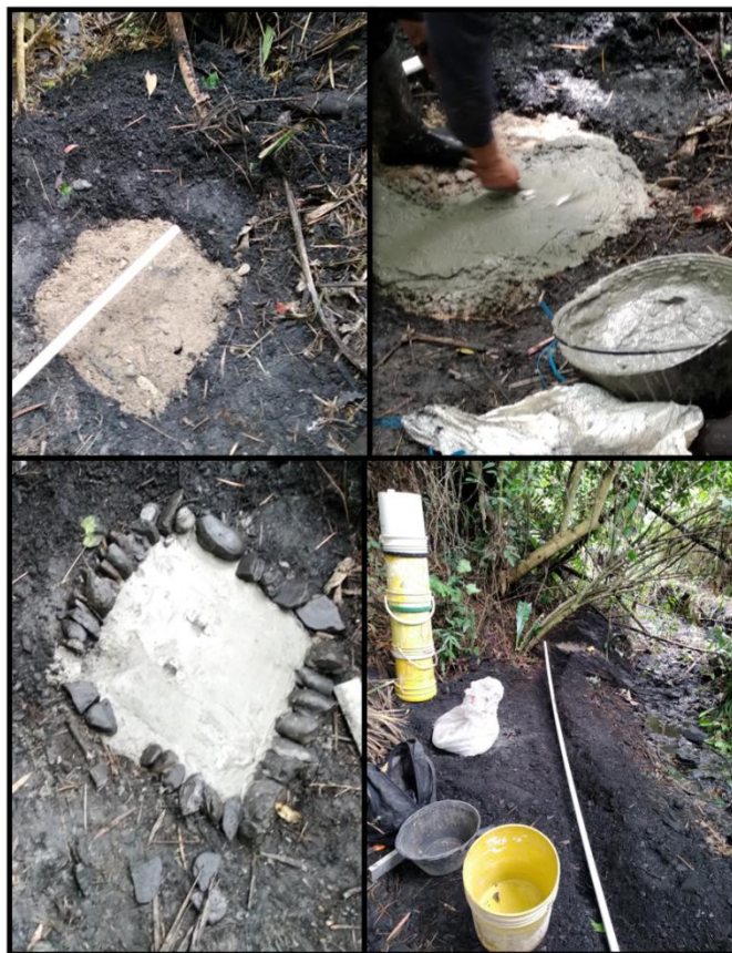
Figura 39. Fundición placas de concreto
