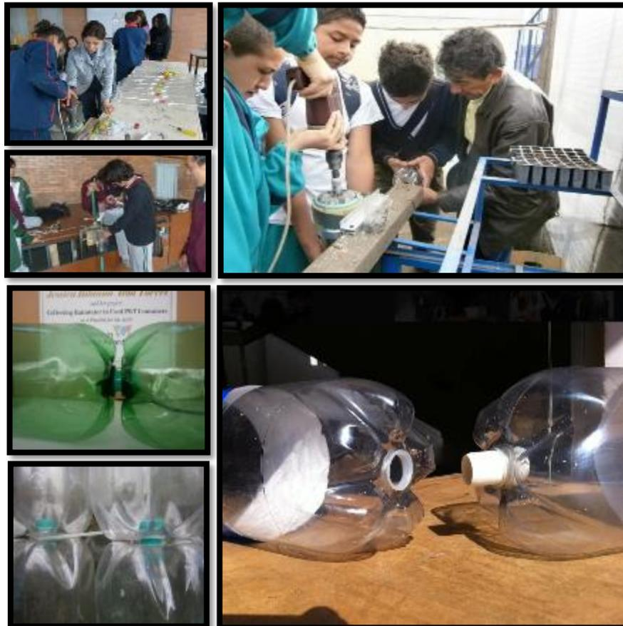
*Ilustración 14 Perforación y unión de las botellas PET. Fuente: (Autor,2017)*
