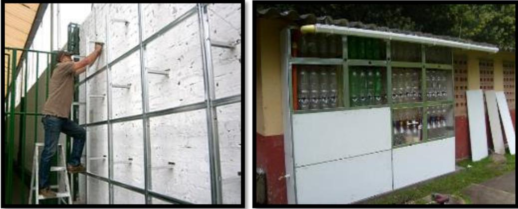
**Ilustración 16** Estructura Soporte sistema Ekomuro H2O+. Fuente: (Autor,2017)
